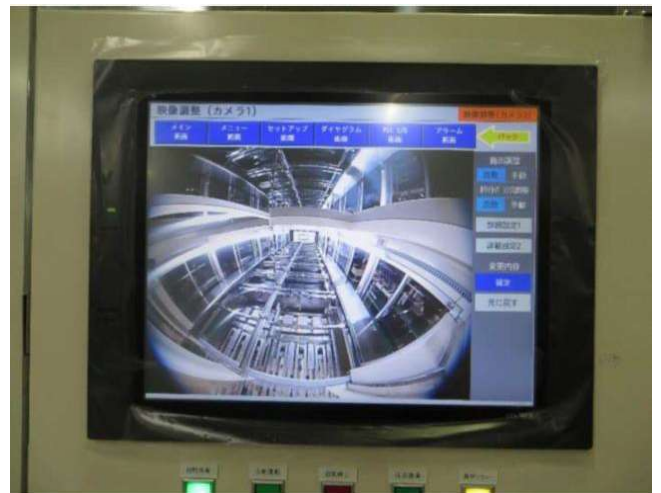
カメラ映像は制御盤モニターに表示されます。
